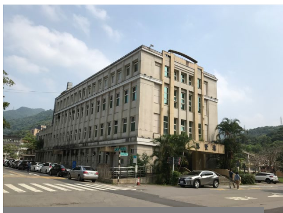
基地上舊有建築物(憩賢樓已拆除)
